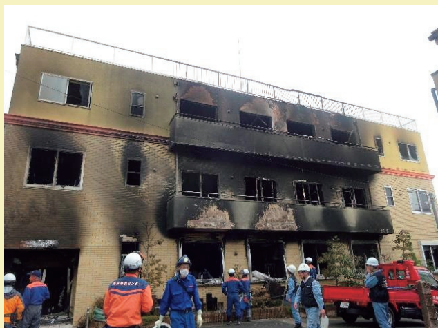
出火建物外観
